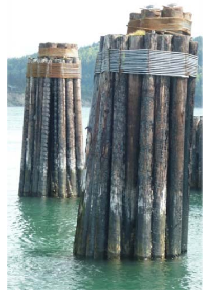
Anacortes Creosote Pilings
